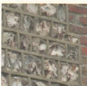
*Joints 'au ruban' qui cachent l'irrégularité des blocs d'appareils et tentent de redonner une géométrie parfaite aux éléments maçonnés*
